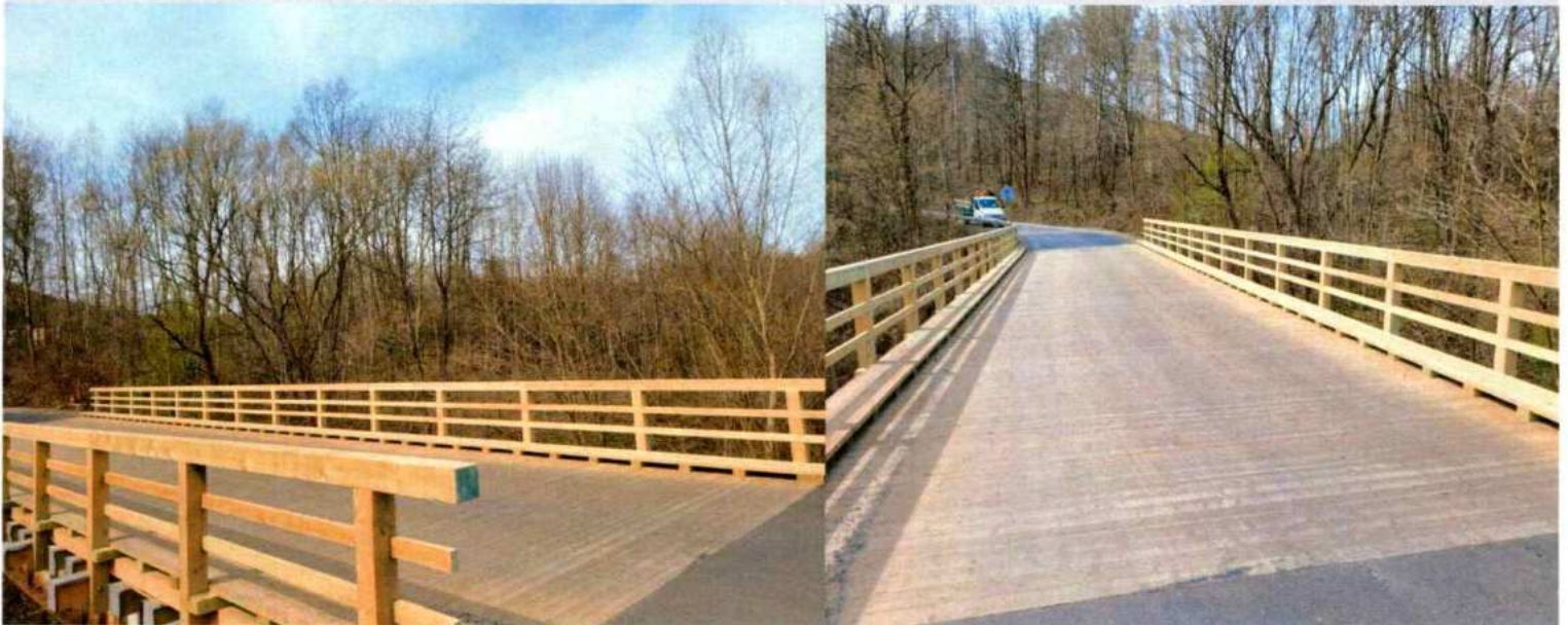
Remont mostu w miejscowości Bielanka w km 1+248.
