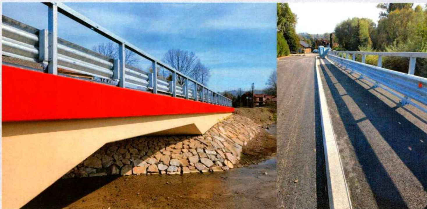
Odbudowa dwóch mostów w ciągu drogi powiatowej 1464K Bobowa – Brzana. Most I.
