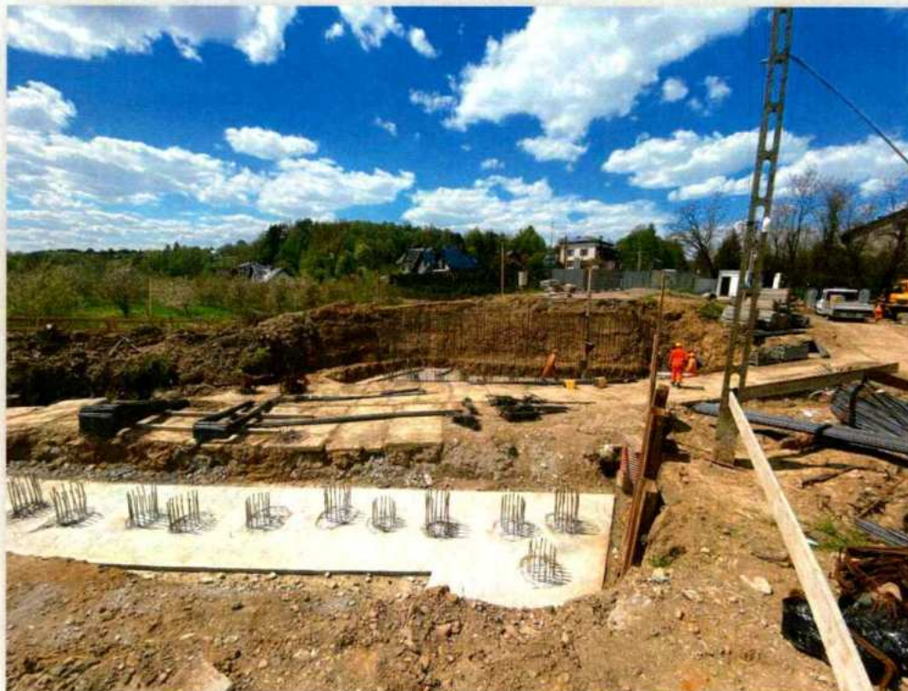
Odbudowa dwóch mostów w ciągu drogi powiatowej 1464K Bobowa. Most I.
