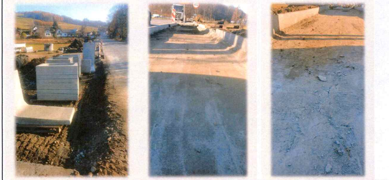
Przebudowa drogi powiatowej w ciągu drogi powiatowej 1498K Ropa – Wysowa Zdrój – Blechnarka – Granica Państwa polegająca na budowie chodnika w km 2+579 do km 3+077 w m. Ropa
