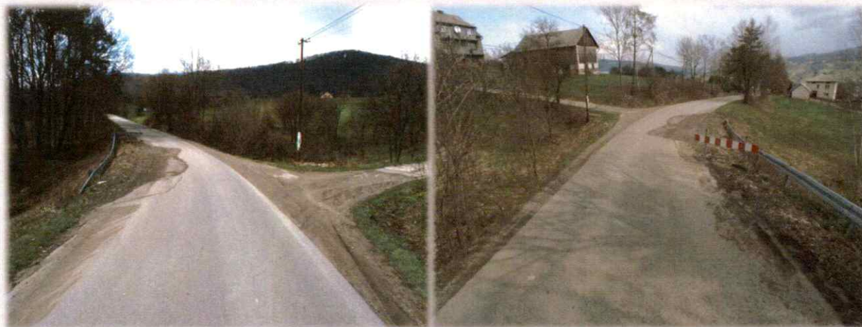
Stabilizacja osuwiska w miejscowości Ropa w ciągu drogi powiatowej 1504K Ropa- Wawrzka -Florynka wraz z odbudową drogi w km 2+112 - 2+149 i przepustu w km 2+135.
