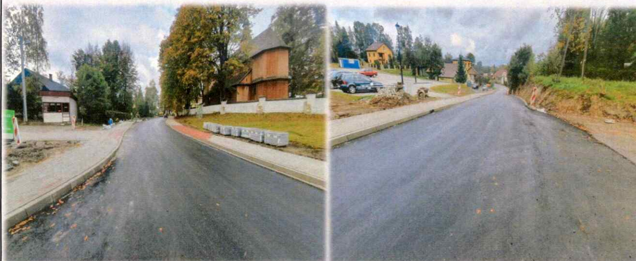
Przebudowa drogi powiatowej 1466K Stróże - Polna Łuźna na odcinku I - w km od 3+738 do km 4+518, na odcinku II - w km od 4+832 do km 5+297 w miejscowości Szalowa
