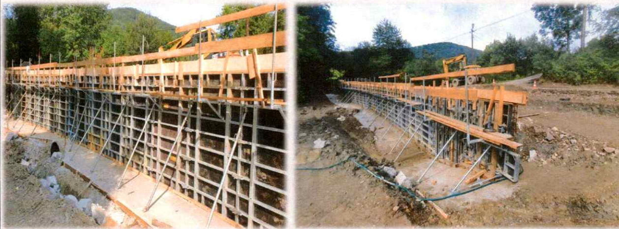
Stabilizacja osuwiska w miejscowości Ropa w ciągu drogi powiatowej 1504K Ropa- Wawrzka -Florynka wraz z odbudową drogi w km 2+112 - 2+149 i przepustu w km 2+135.
