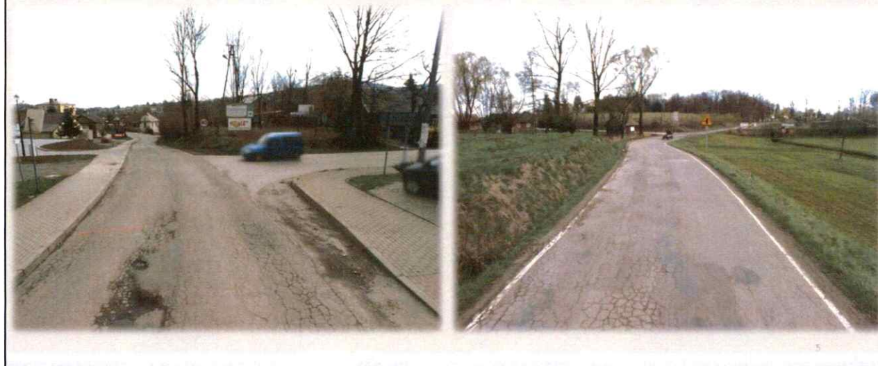
Przebudowa drogi powiatowej 1466K Stróże - Polna Łuźna na odcinku I - w km od 3+738 do km 4+518, na odcinku II - w km od 4+832 do km 5+297 w miejscowości Szalowa
