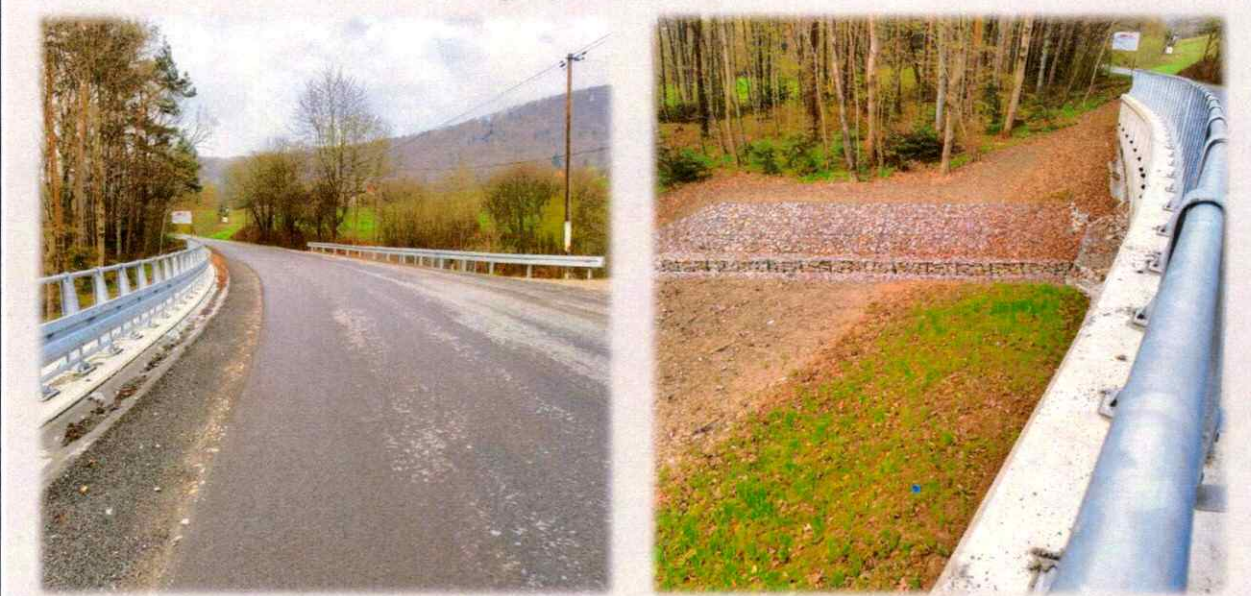
Stabilizacja osuwiska w miejscowości Ropa w ciągu drogi powiatowej 1504K Ropa- Wawrzka -Florynka wraz z odbudową drogi w km 2+112 - 2+149 i przepustu w km 2+135.
