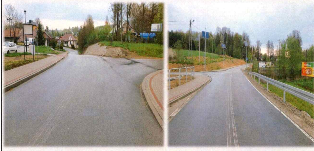
Przebudowa drogi powiatowej 1466K Stróże - Polna Łuźna na odcinku I - w km od 3+738 do km 4+518, na odcinku II - w km od 4+832 do km 5+297 w miejscowości Szalowa
