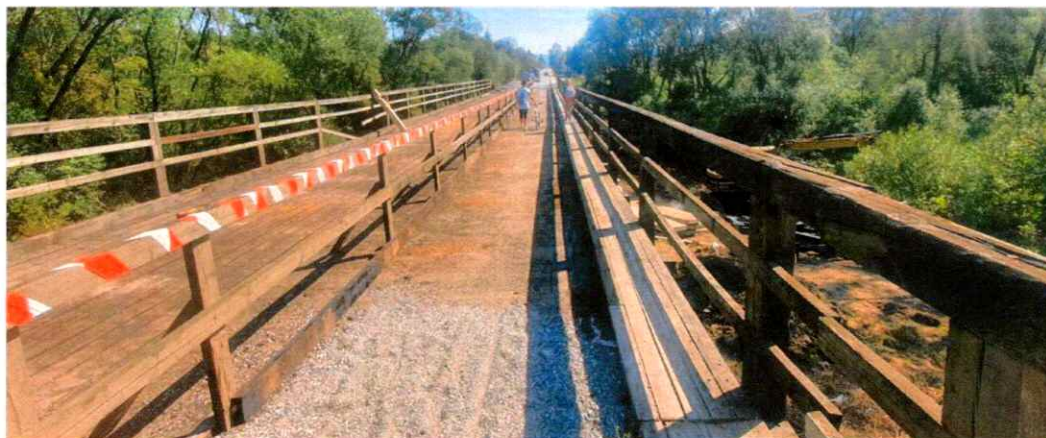
Wykonanie doraźnego zabezpieczenia mostu znajdującego się w ciągu drogi powiatowej 1496K Gładyszów – Uście Gorlickie w km 9+931
