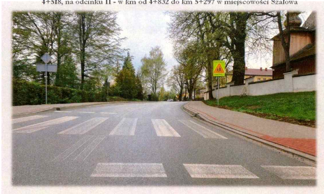
Przebudowa drogi powiatowej 1466K Stróże - Polna Łuźna na odcinku I - w km od 3+738 do km 4+518, na odcinku II - w km od 4+832 do km 5+297 w miejscowości Szalowa
