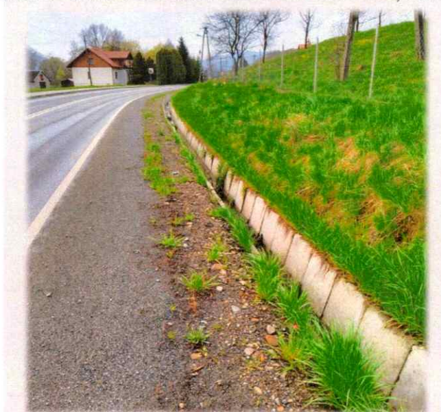
Wykonanie umocnienia rowu elementami betonowymi w ciągu drogi powiatowej 1498 K Ropa - Wysowa Zdrój - Blechnarka - Granica Państwa w km 1+820-1+955 w miejscowości Ropa
