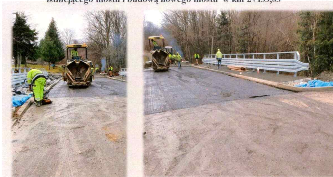
Rozbudowa drogi powiatowej 1507K Szymbark - Bystra - Szalowa wraz z rozbiórką istniejącego mostu i budową nowego mostu w km 2+135,83
