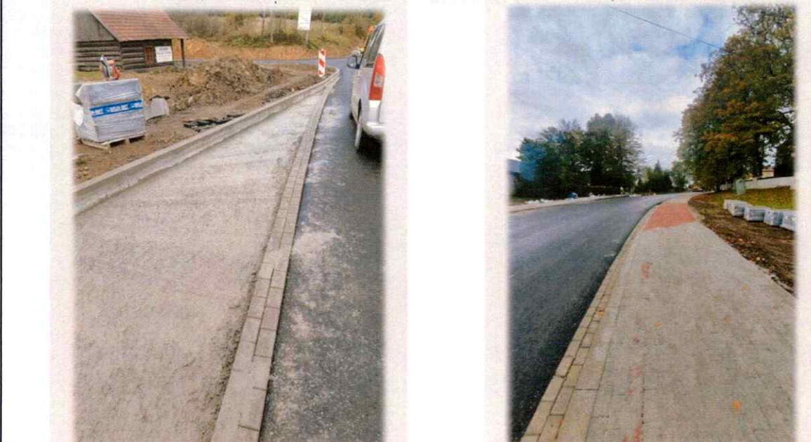
Przebudowa drogi powiatowej 1466K Stróże - Polna Łuźna na odcinku I - w km od 3+738 do km 4+518, na odcinku II - w km od 4+832 do km 5+297 w miejscowości Szalowa
