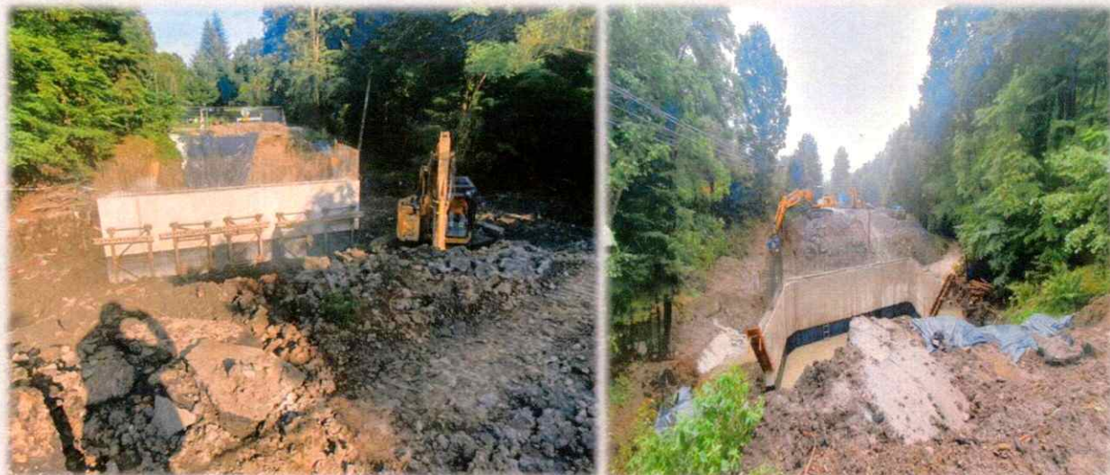
Rozbudowa drogi powiatowej 1507K Szymbark - Bystra - Szalowa wraz z rozbiórką istniejącego mostu i budową nowego mostu w km 2+135,83
